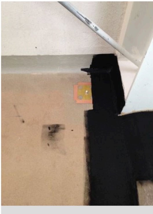
Die ableitfähige Erdungsplatte wurde gesetzt...
