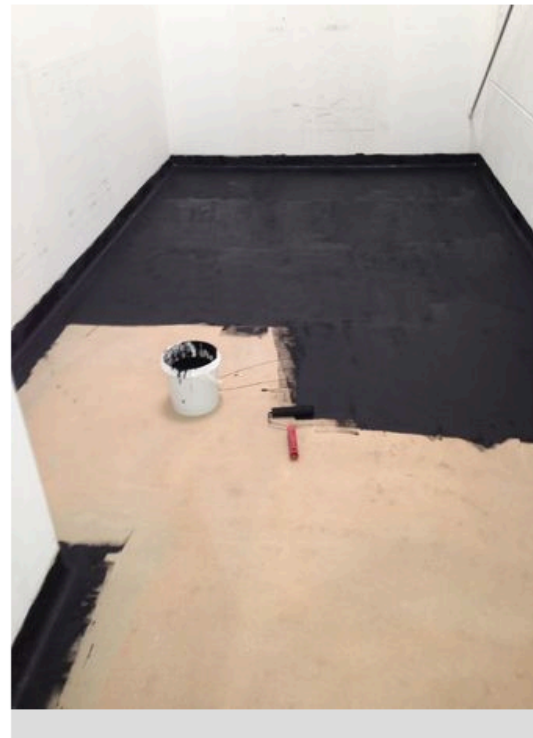
... und anschliessend die schwarze Leitschicht appliziert.
