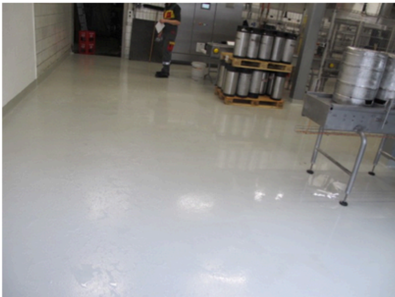
...nach Applikation des RAROC-Bodenbelags.
